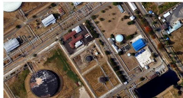
Gambar 7. Overview Instalasi Proses MGS Balongan
