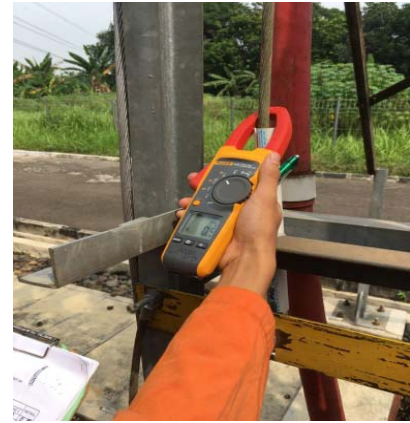
Gambar 3.4. Pelaksanaan Monitoring Arus Bocor pada kondisi beroperasi
