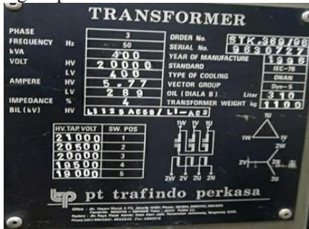
Gambar 12. Name Plate Transformator.
