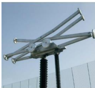
Gambar 8. Pemisah Pantograph
