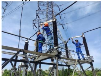
Gambar 14. Perbaikan Hotspot
