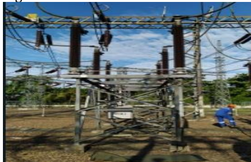
Gambar 1. Pemisah(PMS)/Disconnecting Switch
