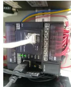
**Gambar 6.** Indicator CP1W tidak terhubung antara PLC dan HMI
