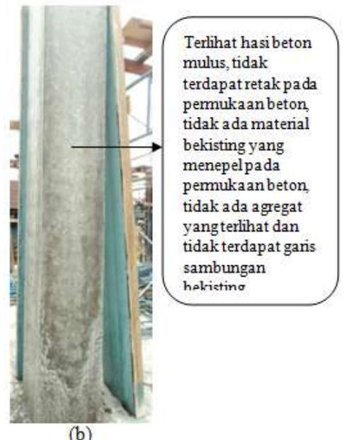
Gambar 1. Hasil beton dengan bekisting berbahan material alam (a) dan fiber (b). Berdasarkan dari standarisasi hasil beton finish PT. Wijaya Karya (Persero), Tbk. terlihat hasil beton finish pada bekisting bermaterial fiber lebih baik dibandingkan bekisting bermaterial alam. Hal ini juga berpengaruh pada efisiensi waktu pelaksanaan dan biaya pekerjaan beton.
