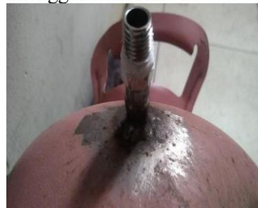
Gambar 4.1 Hasil pengelasan nipple pada tabung.
