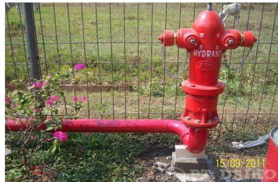
Gambar 4. Bentuk Hydrant Pillar
