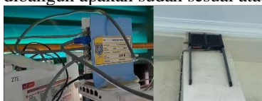
Gambar Jaringan Yang Sudah Dibangun
