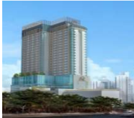
Gambar 1 Proyek Apartemen Atlanta, Depok
