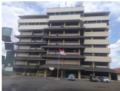
Gambar 4.2 Tampak Gedung Kampus (Sumber : Foto Pribadi, 2025)
