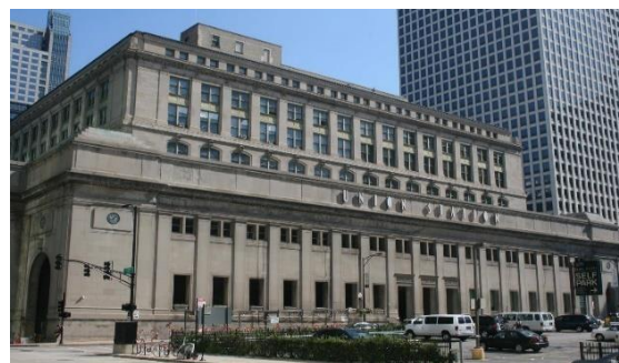
Gambar 3. 5 : Chicago stasiun kereta api Sumber : Google
