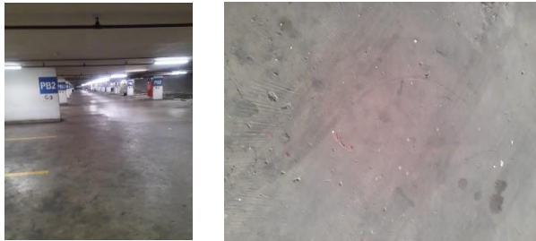
Gambar 5. Perkerasan lapisan lantai parkir (Sumber: Dokumentasi Pribadi, 2023)
