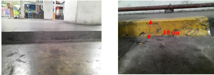
Gambar 8. Perbedaan Level Lantai Jalur Pedestrian pada Area Parkir Depok Town Square Sumber: Dokumentasi Pribadi, 2022
