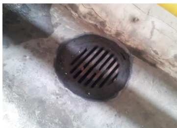
Gambar 10. Floor drain pada tepi gedung parkir Depok Town Square Sumber: Dokumentasi Pribadi, 2022
