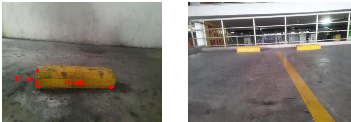
Gambar 7. Penghalang ban ( wheel stops ) pada area parkir Depok Town Square Sumber: Dokumentasi Pribadi, 2022
