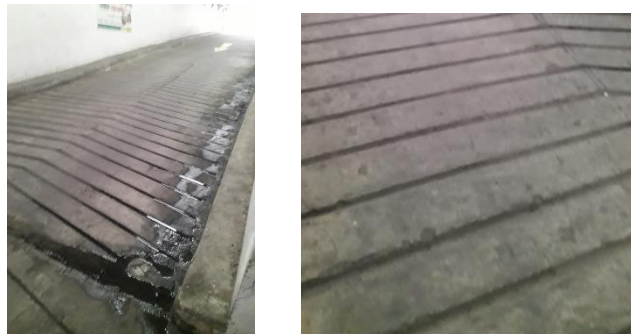
Gambar 3. Finishing lantai ramp (Sumber: Dokumentasi Pribadi, 2023)
