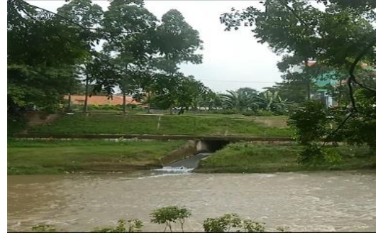
Gambar 4.2 Drainase di bantaran kanal
