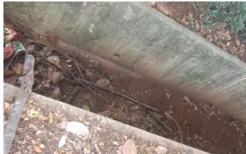
Gambar 4.3 Drainase di pinggir jalan raya (Sumber: data pribadi, 2022)
